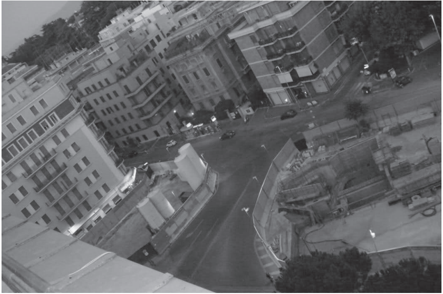
2011 - Piazza Annibaliano – cantiere metro B1
